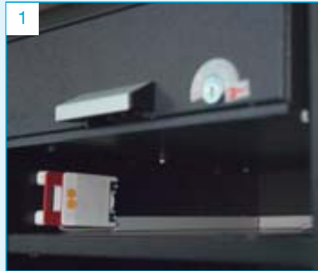
1 Die Überfallmeldeanlage ist direkt an der Wechselkasse für Kunden nicht sichtbar.
