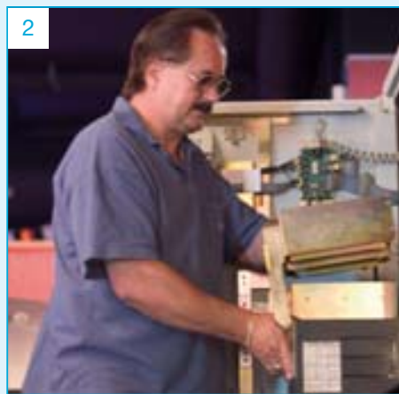
2 Wechselautomaten sind in festgelegten Fristen zu warten und zu prüfen.
